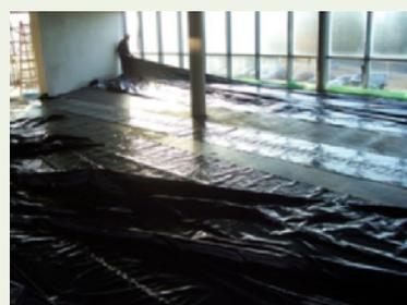
4. Nachfolgend wird eine PE- Folie verlegt und vor dem Randdämmstreifen hochgezogen bis über die fertige Oberfläche.
