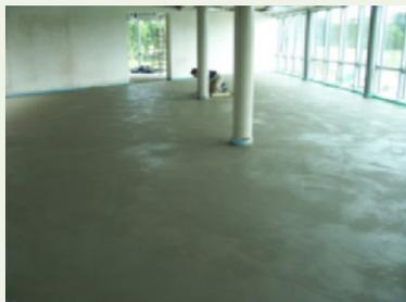
7. Nach Einbau Estrich kann wie gewohnt der entsprechende Oberbelag verlegt werden. Z. B. auch mit einer entsprechenden **SPEBA DAMTEC** Trittschall- und Entkoppelungsbahn.
