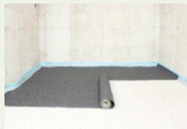
2. **SPEBA DAMTEC-estra** Dämmunterlage vollflächig im Raum auslegen und etwas größer zuschneiden. Den Belag 1 Tag (mind. 24 Stunden) entspannen und akklimatisieren lassen.
