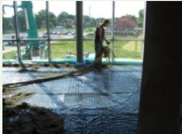
5. Zur Vermeidung von Schallbrücken darf kein Estrich in die Trittschalldämmunterlage gelangen. Der Einbau des Estrichs kann anschließend nach den geltenden Normen und Vorschriften eingebaut werden.
