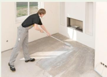
1. Untergrund gründlich abfegen oder absaugen. Zum Ausgleich von Unebenheiten die Untergründe mit geeigneten Vorstrichen oder Grundierungen behandeln und mit geeigneten Spachtelmassen ausgleichen.
