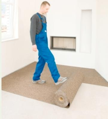
2. **SPEBA DAMTEC-standard** vollflächig und quer zur späteren Verlegerichtung des Oberbelages im Raum auslegen und zuschneiden. **SPEBA DAMTEC-standard** mindestens 24 Stunden entspannen und akklimatisieren lassen.
