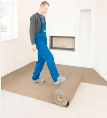
2. **SPEBA DAMTEC-black uni** vollflächig und quer zur späteren Verlegerichtung des Oberbelages im Raum auslegen und zuschneiden. **SPEBA DAMTEC-black uni** mindestens 24 Stunden entspannen und akklimatisieren lassen.
