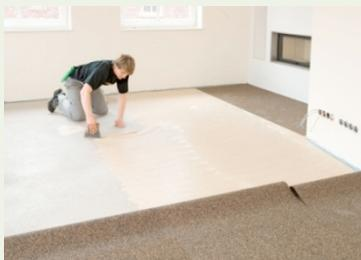
4. **SPEBA DAMTEC-black uni** zur Mitte des Raums zurückschlagen und die Verklebung der Unterlage nach den Vorgaben der Kleberhersteller durchführen.
