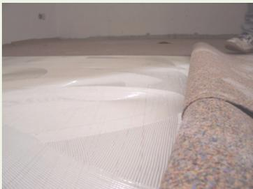
4. **SPEBA DAMTEC-resistant cork G** mit der ungeschliffenen Seite oder **SPEBA DAMTEC-resisten cork** faltenfrei in das Klebstoffbett einlegen und sorgfältig anreiben und anwalzen. Die zweite Hälfte des Raumes auf die gleiche Weise bearbeiten.
