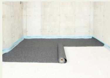
2. **SPEBA DAMTEC-estra 3D** Dämmunterlage vollflächig im Raum auslegen und etwas größer zuschneiden. Den Belag 1 Tag (mind. 24 Stunden) entspannen und akklimatisieren lassen.
