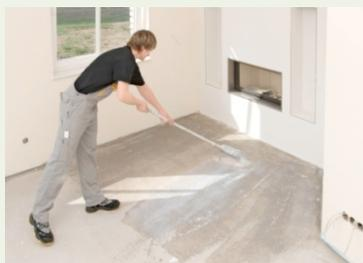
1. Untergrund gründlich abfegen oder absaugen. Zum Ausgleich von Unebenheiten die Untergründe mit geeigneten Vorstrichen oder Grundierungen behandeln und mit geeigneten Spachtelmassen ausgleichen.
