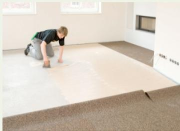
4. **SPEBA DAMTEC-standard** zur Mitte des Raums zurückschlagen und die Verklebung der Unterlage nach den Vorgaben der Kleberhersteller durchführen.
