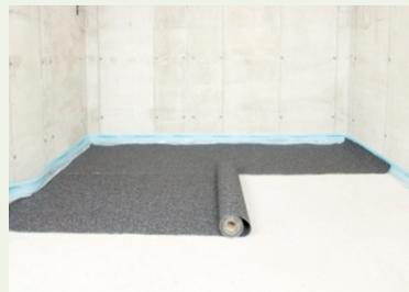
2. **SPEBA DAMTEC-wave 3D** Dämmunterlage vollflächig im Raum auslegen und etwas größer zuschneiden. Den Belag 1 Tag (mind. 24 Stunden) entspannen und akklimatisieren lassen.
