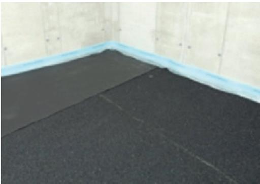
2. SPEBA® DAMTEC® system Dämmunterlage vollflächig im Raum mit Granulaten nach oben, auslegen und etwas größer zuschneiden.
