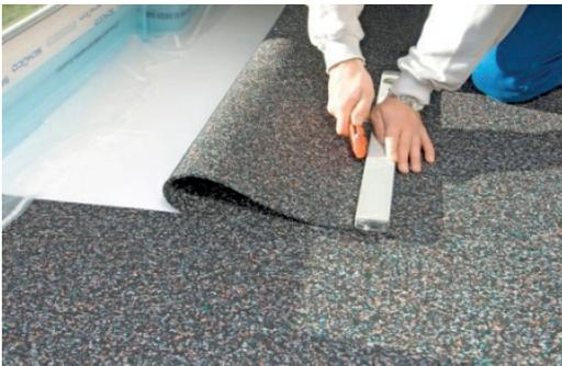
3. Zum Zuschneiden kann ein Cutter Messer und eine Anlegeschiene verwendet werden.
