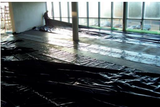
4. Nachfolgend wird eine PE-Folie verlegt und vor dem Randdämmstreifen hochgezogen bis über die fertige Oberfläche.
