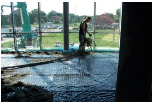
5. Zur Vermeidung von Schallbrücken darf kein Estrich in die Trittschalldämmunterlage gelangen.
