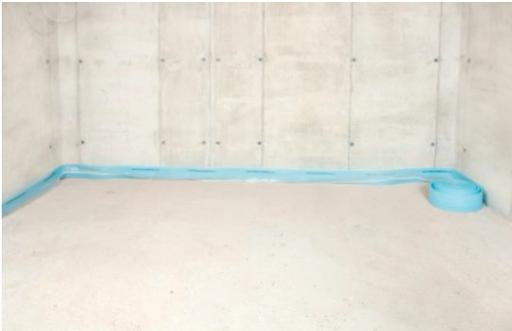
1. Untergrund gründlich abfegen oder absaugen. Um Schallbrücken zu vermeiden ist vor Einbringen der Elemente für den Fußbodenaufbau zu allen aufgehenden Bauteilen, wie Wänden, Rohrleitungen und anderen ein Randdämmstreifen zu verlegen. Der Randdämmstreifen muss ausreichend dimensioniert sein und bis über die fertige Oberbelagshöhe gezogen werden.
