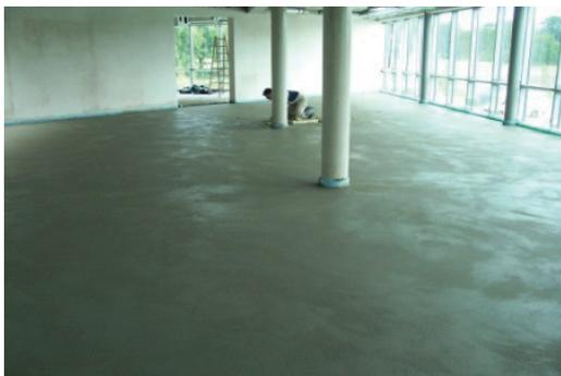
7. Nach Einbau Estrich kann wie gewohnt der entsprechende Oberbelag verlegt werden. Z.B. auch mit einer entsprechenden SPEBA® DAMTEC® Trittschall- und Entkoppelungsbahn.
