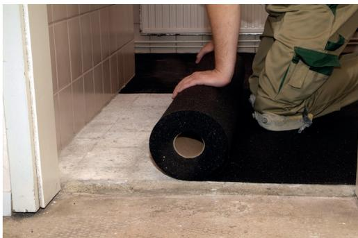
3. SPEBA® DAMTEC® standard vollflächig im Raum auslegen und etwas größer zuschneiden. SPEBA® DAMTEC® standard mindestens 24 Stunden entspannen und akklimatisieren lassen.
