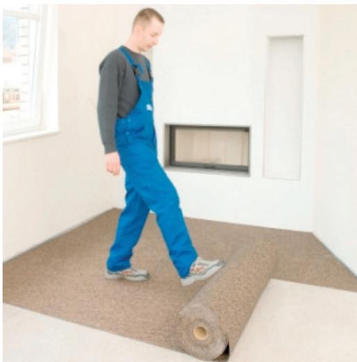
2. SPEBA® DAMTEC® standard vollflächig und quer zur späteren Verlegerichtung des Oberbelages im Raum auslegen und zuschneiden. SPEBA® DAMTEC® standard mindestens 24 Stunden entspannen und akklimatisieren lassen.
