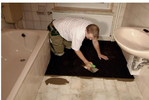
6. Dabei SPEBA® DAMTEC® standard faltenfrei in das frische Mörtelbett einlegen und mit Hilfe der glatten Seite der Zahnkelle oder einer Glättkelle andrücken und so abstreichen, dass keine Lufteinschlüsse unter der Bahn verbleiben.
