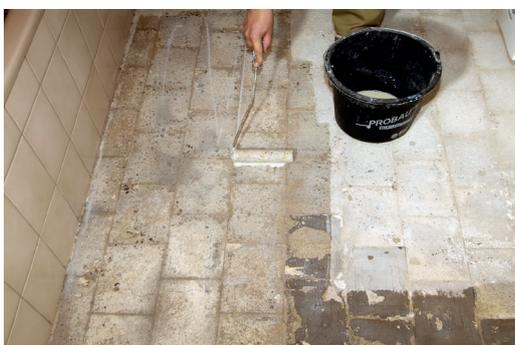
2. Zum Ausgleich von Unebenheiten die Untergründe mit geeigneten Vorstrichen oder Grundierungen behandeln und mit geeigneten Spachtelmassen ausgleichen.
