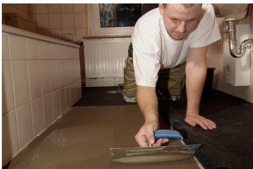
5. SPEBA® DAMTEC® standard zur Mitte des Raumes zurückschlagen und die Verklebung der Unterlage nach den Vorgaben des Kleberherstellers durchführen.
