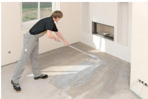
1. Untergrund gründlich abfegen oder absaugen. Zum Ausgleich von Unebenheiten die Untergründe mit geeigneten Vorstrichen oder Grundierungen behandeln und mit geeigneten Spachtelmassen ausgleichen.
