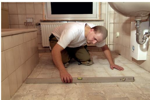
1. Alte, lose Fliesenbeläge ggf. entfernen. Untergrund gründlich abfegen oder absaugen.
