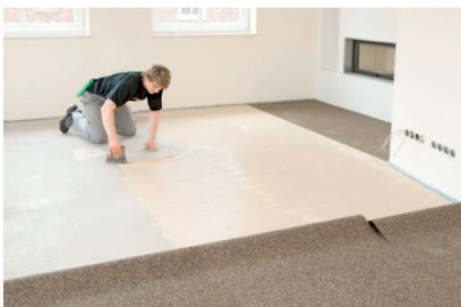
4. SPEBA® DAMTEC® standard zur Mitte des Raumes zurückschlagen und die Verklebung der Unterlage nach den Vorgaben der Kleberhersteller durchführen.
