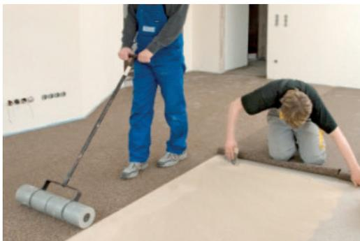
4. SPEBA® DAMTEC® resistant cork G mit der ungeschliffenen Seite oder SPEBA® DAMTEC® resistant cork faltenfrei in das Klebstoffbett einlegen und sorgfältig anreiben und anwalzen. Die zweite Hälfte des Raumes auf die gleiche Weise bearbeiten.
