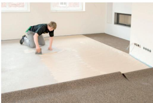
3. SPEBA® DAMTEC® resistant cork (G) passgerecht zuschneiden und zur Mitte des Raumes zurückschlagen und die Verklebung der Unterlage nach den Vorgaben der Kleberhersteller durchführen. Bei SPEBA® DAMTEC® resistant cork G muss die geschliffene Rolleninnenseite nach der Verlegung oben sein.
