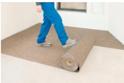
2. SPEBA® DAMTEC® resistant cork (G) vollflächig und quer zur späteren Verlegerichtung des Oberbelages im Raum auslegen und zuschneiden. SPEBA® DAMTEC® resistant cork (G) mindestens 24 Stunden entspannen und akklimatisieren lassen.
