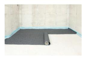
2. SPEBA® DAMTEC® estra 3D Dämmunterlage vollflächig und im Raum auslegen und etwas größer zuschneiden. SPEBA® DAMTEC® estra 3D mindestens 24 Stunden entspannen und akklimatisieren lassen.
