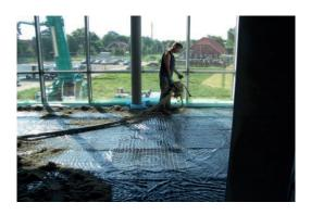
5. Zur Vermeidung von Schallbrücken darf kein Estrich in die Trittschalldämmunterlage gelangen.
