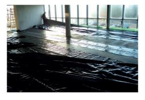
4. Nachfolgend wird eine PE-Folie verlegt und vor dem Randdämmstreifen hochgezogen bis über die fertige Oberfläche.
