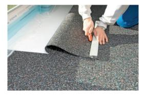
3. Zum Zuschneiden kann ein Cutter Messer und eine Anlegeschiene verwendet werden.
