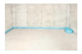
1. Untergrund gründlich abfegen oder absaugen. Mörtelreste entfernen. Zur Vermeidung von Schallbrücken zu allen aufgehenden Bauteilen, wie Wänden, Rohrleitungen und anderen Randdämmstreifen verlegen.
