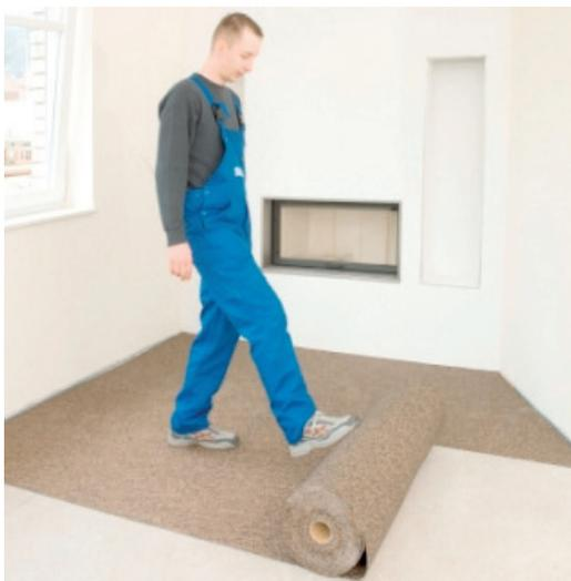
2. SPEBA® DAMTEC® black uni vollflächig und quer zur späteren Verlegerichtung des Oberbelages im Raum auslegen und zuschneiden. SPEBA® DAMTEC® black uni mindestens 24 Stunden entspannen und akklimatisieren lassen.
